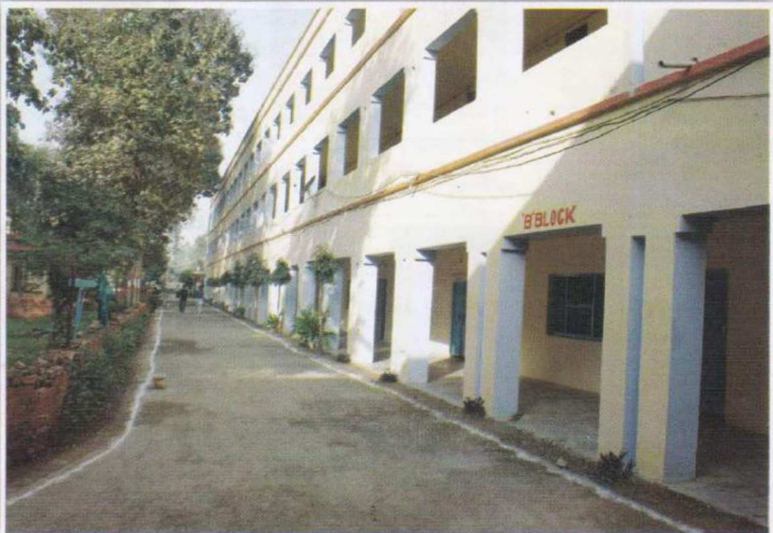
कम्प्यूटर एवं बायो साइंस भवन
